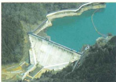
改修後タム全景
